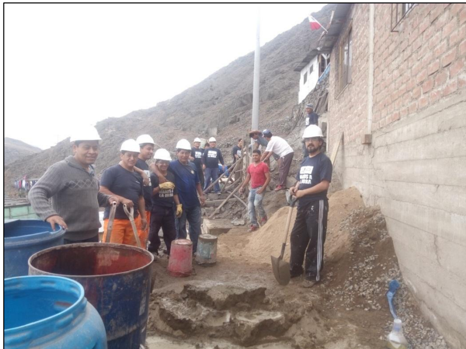
Inicio de Obra
